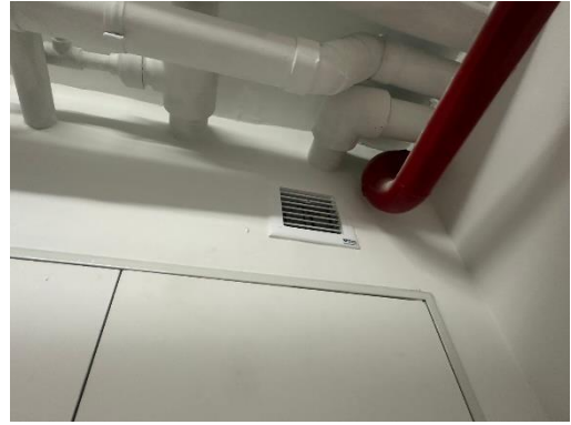
รูปที่ 13 พัดลมดูดอากาศห้องพักขยะ
